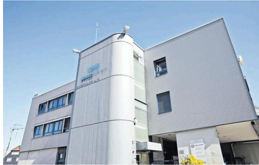
Während die Räume in der Werkstatt für Menschen mit Behinderung stark sanierungsbedürftig sind, wirken die Büroräume modern und sind noch voll funktionstüchtig.
